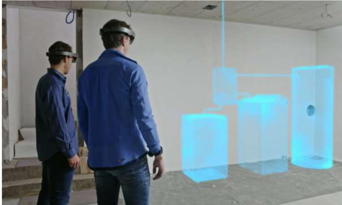
Im Keller sieht man dank Mixed Reality Wärmepumpen für Heizung und Wasser sowie der Solarstromspeicher
