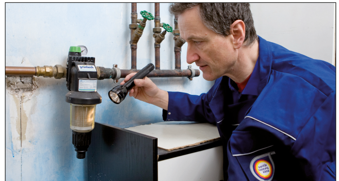
txn. Die SHK-Fachbetriebe in der Region stellen einen verlässlichen Notdienst bei Störungen im Sanitär-, Heizungs- und Klimabereich sicher. Foto: ZVSHK/txn
