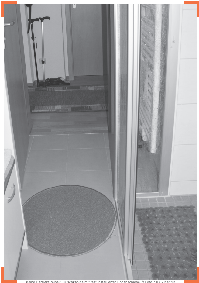
Keine Barrierefreiheit: Duschkabine mit fest installierter Bodenschiene. // Foto: SIBIS Institut
