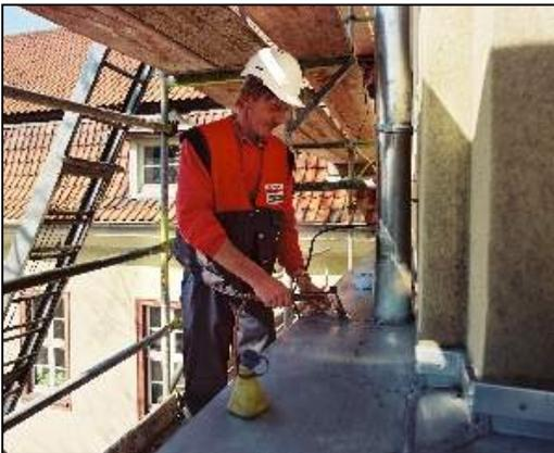
Die in der Klempnertechnik verwendeten Befestigungsmittel und die Unterkonstruktion müssen die enormen Windkräfte sicher aufnehmen um ein Ablösen der Dach- oder Fassadenelemente zu verhindern. Die erforderlichen Maßnahmen sind vom Planer, aber auch vom ausführenden Klempnerfachbetrieb zu berücksichtigen.
