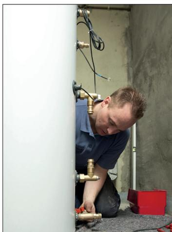
txn. Wer mit Sonnenwärme oder Pellets heizt, braucht fast immer einen Warmwasserspeicher, in dem überschüssige Wärme gespeichert werden kann. Dank erstklassiger Isolierung hält sich die Temperatur sehr lange. Der Einbau erfolgt meist im Rahmen einer Heizungssanierung – die auch in der Corona-Krise sicher und sinnvoll durchgeführt werden kann.
