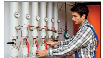
**txn. Eine Frage der Einstellung: Der hydraulische Abgleich sorgt für eine optimale Temperaturverteilung im Heizsystem.**
