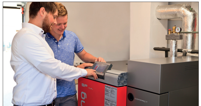
txn. Mit einer vom SHK-Fachmann installierten Pelletheizung profitieren Hausbesitzer gleich mehrfach: Sie wählen einen umweltfreundlichen nachwachsenden Brennstoff mit hohem Heizwert. Und sie sparen langfristig Geld. ZVSHK-Foto: DEPI/txn
