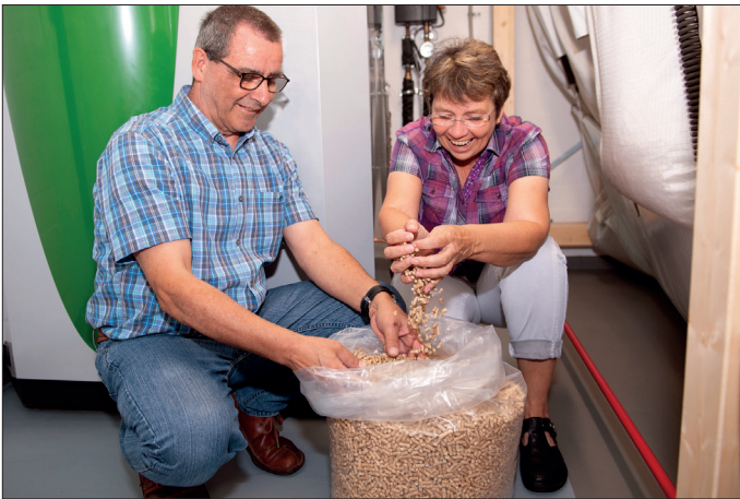
txn. Heizen mit Pellets ist klimafreundlich und schont die Haushaltskasse. Planung und Einbau der Anlage übernimmt der regionale Pelletfachbetrieb. ZVSHK-Foto: DEPI/txn
