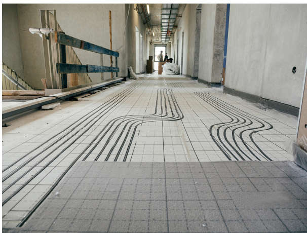
Bild 5: Anbindeleitung in Dämmebene
