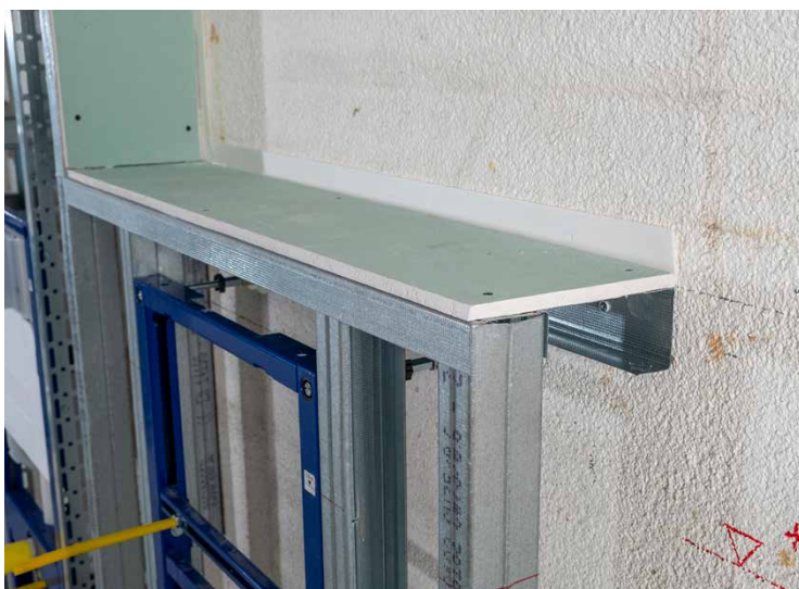
Abb. 10 Beispiel Ausbildung der oberen Abdeckung einer halbhoher Vorsatzschale
