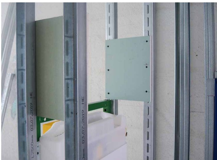
Abb. 11 Beispiel Verlaschung einer Doppelständerwand mit Gipsplattenstreifen
