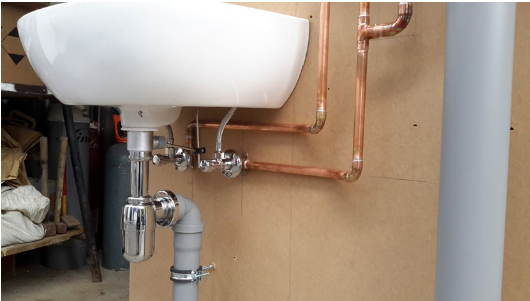
Abbildung 58: Ansicht 3 zum Arbeitsergebnis der praktischen Aufgabe im Prüfungsbereich Versorgungstechnik (Quelle: Innung Leipzig)
