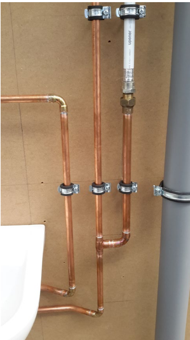
Abbildung 59: Ansicht 4 zum Arbeitsergebnis der praktischen Aufgabe im Prüfungsbereich Versorgungstechnik (Quelle: Innung Leipzig)
