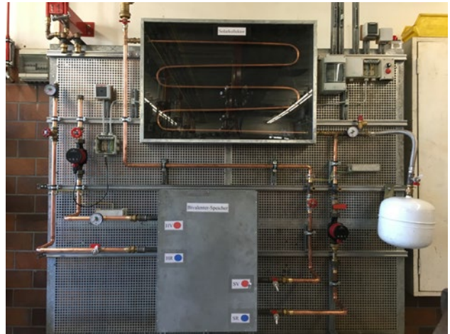
Abbildung 65: Einrichten einer versorgungstechnischen Anlage, Einsatzgebiet erneuerbare Energien und Umwelttechnik (Quelle: BZD)
