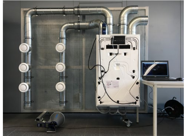
Abbildung 74: Instandhaltung und Inbetriebnahme eines zentralen Lüftungsgerätes, Einsatzgebiet Lüftungs- und Klimatechnik (Quelle: BZD)
