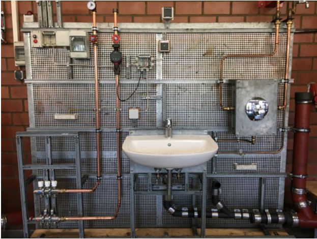
Abbildung 63: Einrichten einer versorgungstechnischen Anlage, Einsatzgebiet Sanitärtechnik (Quelle: BZD)
