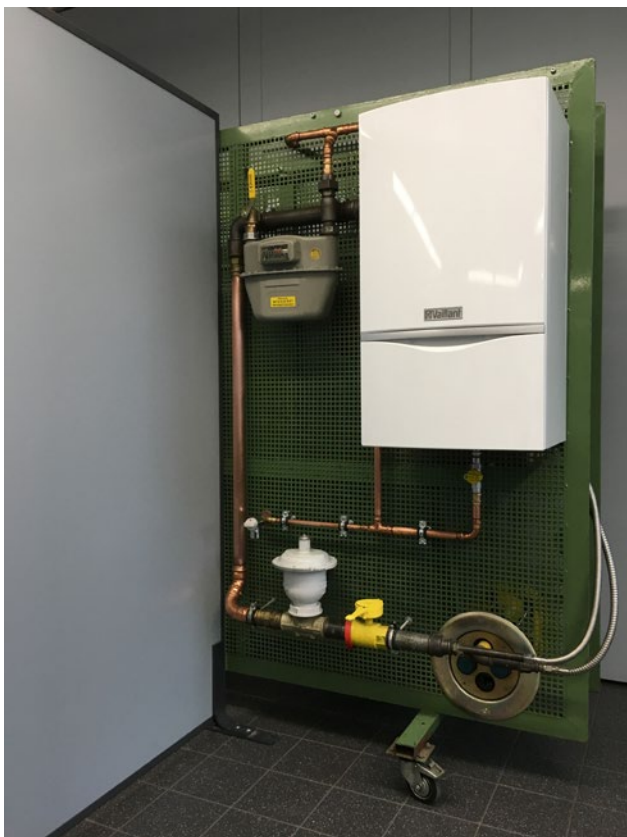
Abbildung 70: Inbetriebnahme einer Gasinstallation, alle Einsatzgebiete (Quelle: BZD)
