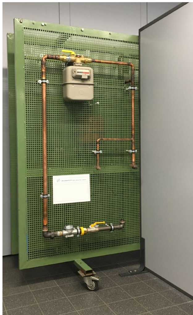
Abbildung 71: Instandhalten und Ändern einer Gasinstallation, alle Einsatzgebiete (Quelle: BZD)
