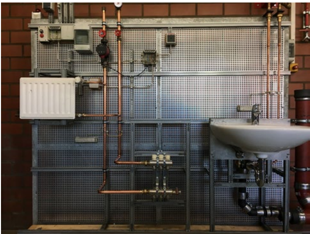
Abbildung 64: Einrichten einer versorgungstechnischen Anlage, Einsatzgebiet Heizungstechnik (Quelle: BZD)
